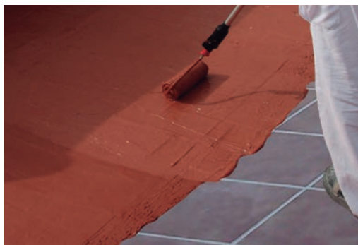
Impermeabilizzazione di piastrelle
