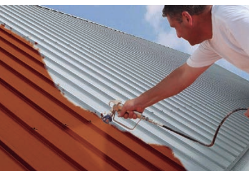
Impermeabilizzazione di un supporto metallico
