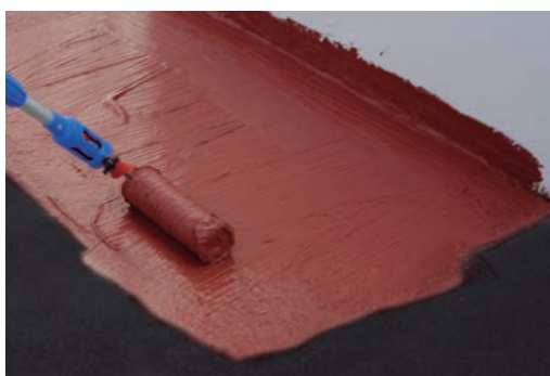
Impermeabilizzazione di carta catramata
