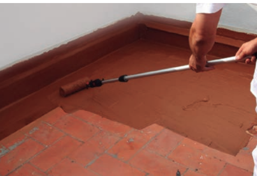
Impermeabilizzazione di terrazze
